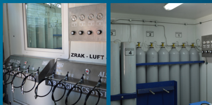
Starke Kompressor Anlage - mit großem Luftspeicher!
